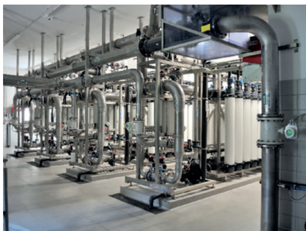
Slika 6: UF-naprava v vodarni Blate.
