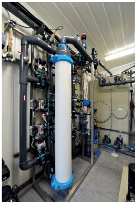
Slika 3: Pilotna ultrafiltracijska naprava z enim UF-membranskim modulom.
