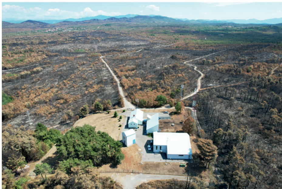
Slika 3: Helikopterska fotografija Sel na Krasu.
