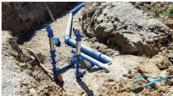
Slika 1: Gradnja vodovoda na odseku ČN Sodražica – VH Sodražica.
