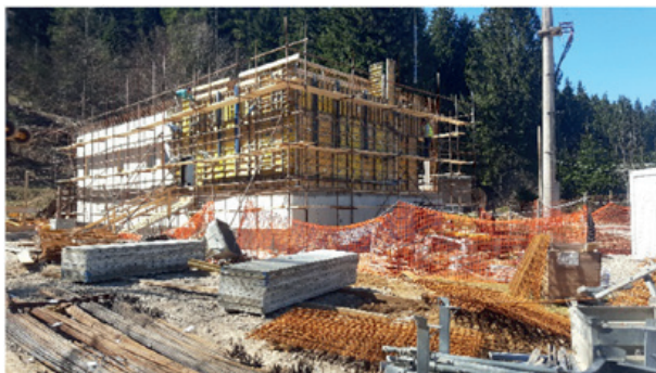
Slika 2: Gradnja čistilne naprave Slovenska vas.
