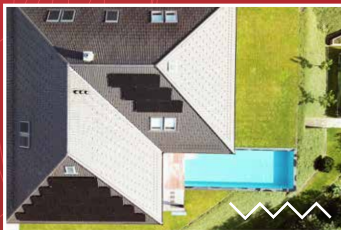
POSTAVITEV SONČNIH ELEKTRARN NA KLJUČ
